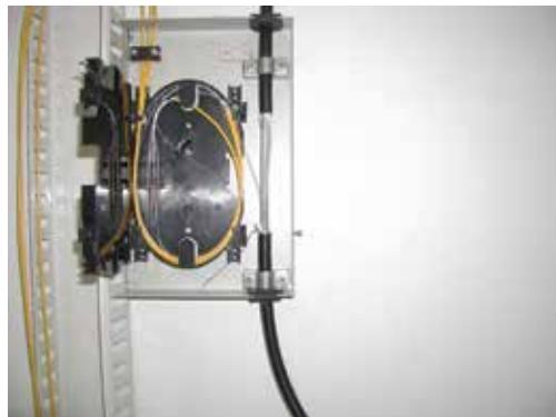
图3 将光纤带转化成为尾纤的接头盒
