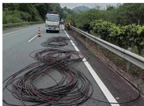
G.654.E 光缆施工现场
