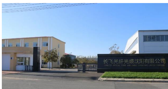
长飞光纤光缆沈阳有限公司
